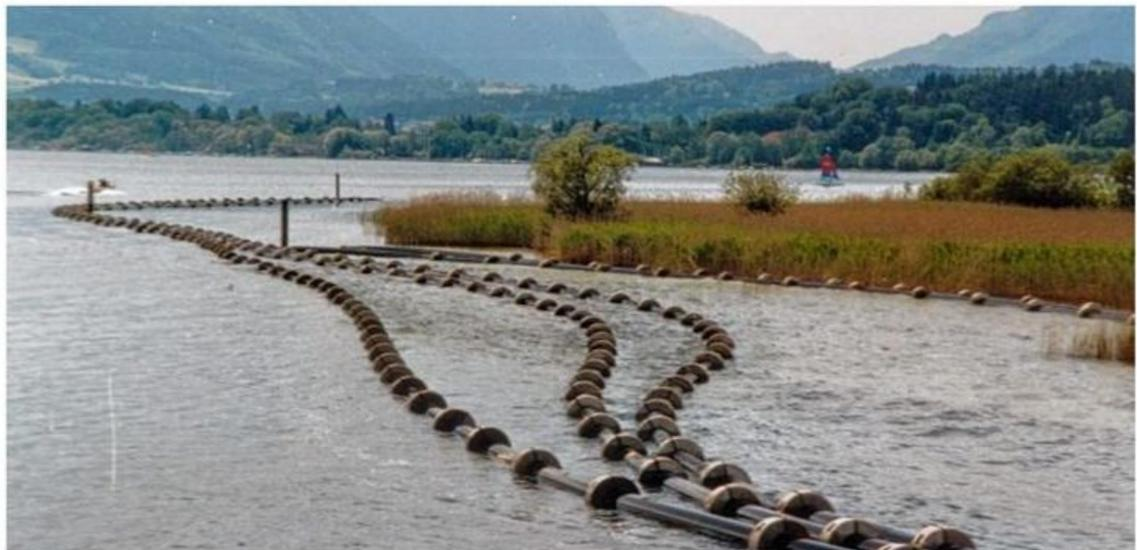
Von Bernau-Felden führt die Südspange des Ringkanals quer durch den Chiemsee. Von Seebruck an Gollenshausen, Gstadt und Breitbrunn vorbei fließen die Abwässer der sogenannten Nordspange ebenfalls in Druckleitungen auf dem Grund des Chiemsees entlang. Betonringe sorgen dafür, dass die Leitungen unten bleiben. Unser Bild zeigt eine der Seeleitungen, bevor sie in den Tiefen des Bayerischen Meeres verschwand.
