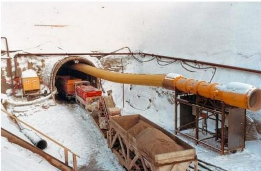
Fast dreieinhalb Meter hoch und fünf Kilometer lang, ist der Stollen, durch den die Hinterlassenschaften der Zivilisation vom Chiemsee bei Prien-Osternach zur Kläranlage nach Stiedering fließen. Beim Bau in den 1980er-Jahren wurde das Material sogar mit einer Bahn abtransportiert.
